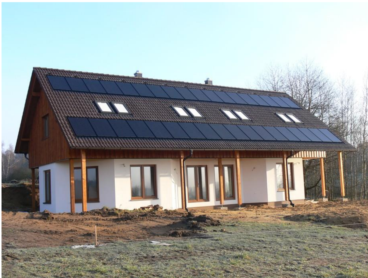
Fotovoltaické pole ostrovního systému tvoří 36 panelů o celkovém nominálním výkonu 9,9 kWp.
